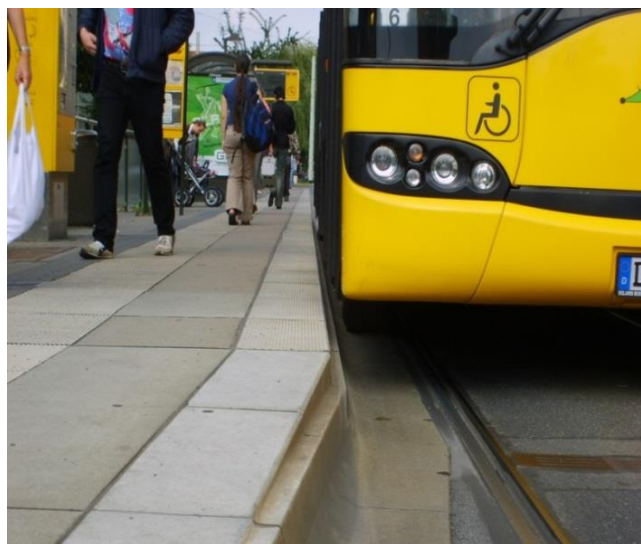
Rys. 9.8. Zalecane ukształtowanie krawędzi peronowej. Źródło: opracowanie własne.
