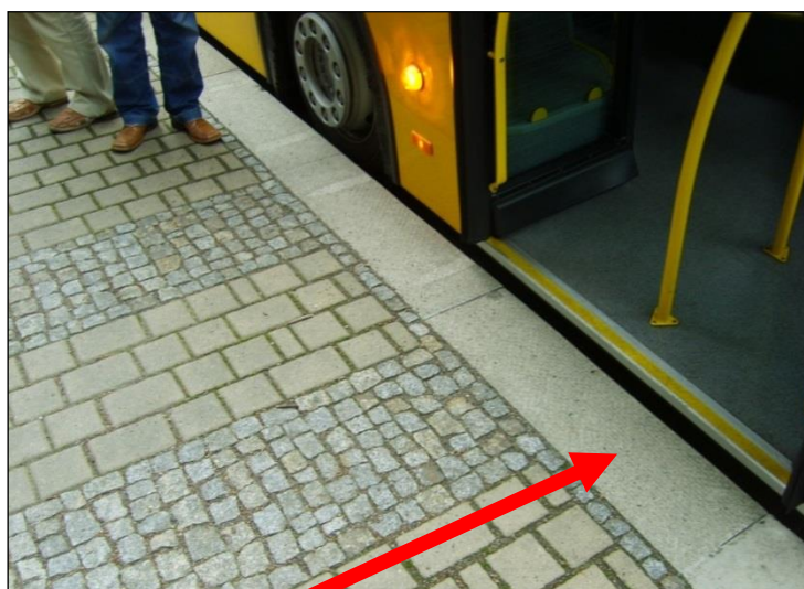
Rys. 9.10. Strefa wejściowa – inny rodzaj nawierzchni naprzeciwko pierwszych drzwi autobusu. Źródło: opracowanie własne.
