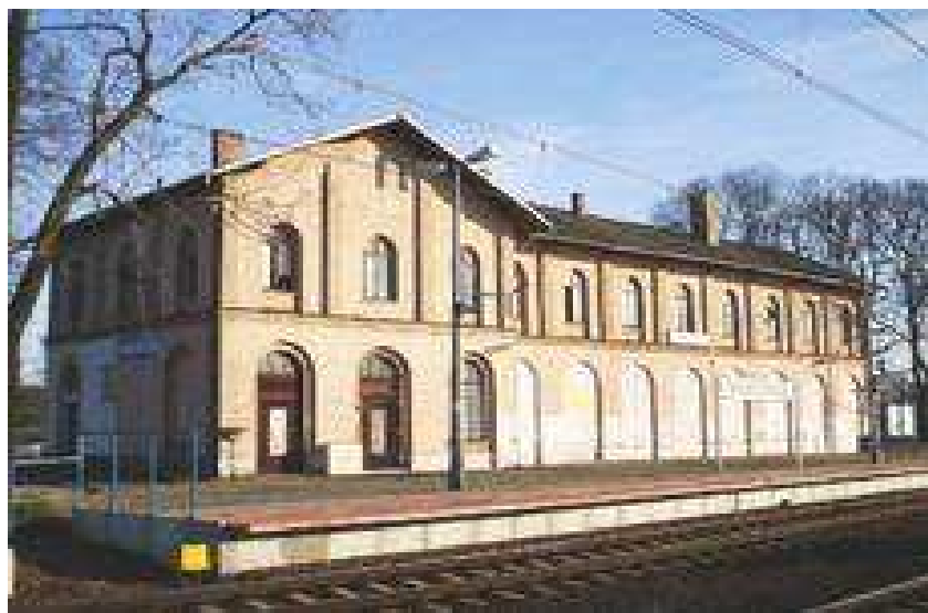
Zdjęcie 6 Budynek Dworca Kolejowego - w chwili obecnej
